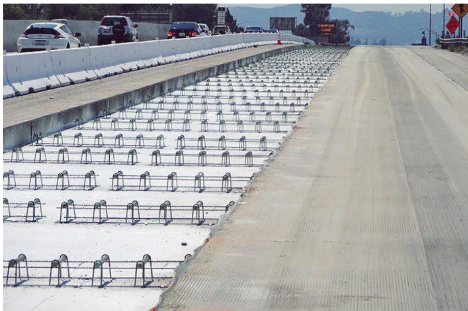
Фото: арматурний каркас – скелет залізобетонної дороги
