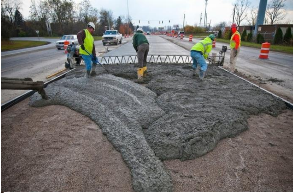
Фото: заливка бетонної суміші дорожньої одежі
