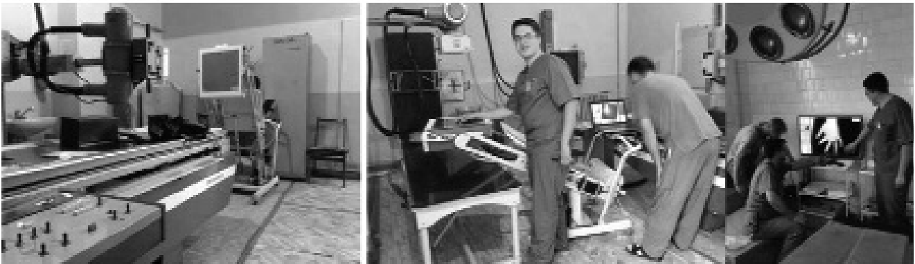
Рис. 2. Монтаж и настройка цифрового приемника в госпитале
